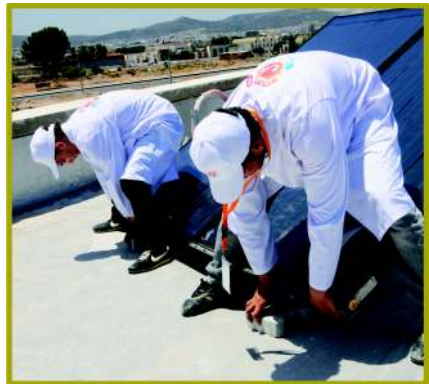
Pose des dalles de fixation du CESI avec vérification de l'alignement horizontal de l'ensemble de montage. Utiliser du mortier pour fixer les dalles au sol et des vis pour fixer la structure aux dalles
