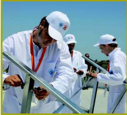
Montage des traverses capteurs - Renforcement de la structure par le montage des croisillons de contreventement
