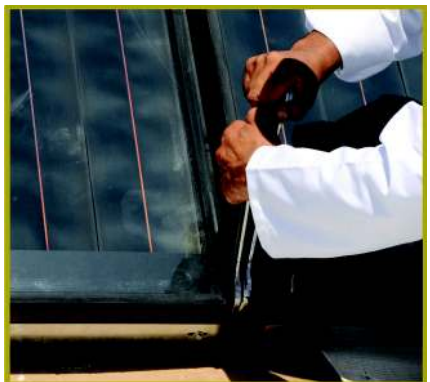
Serrage par clé et contre clé de la liaison inférieure capteurs
