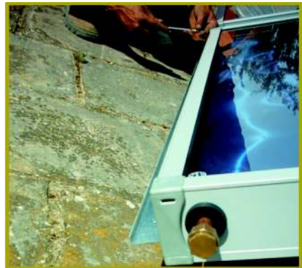
Perforation des réservations de drainage pour éviter les effets néfastes de la condensation dans les capteurs
