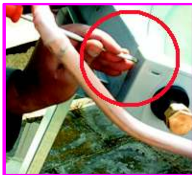
Contrôle des réservations drainage
