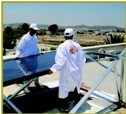
Fixation et positionnement des supports capteurs
