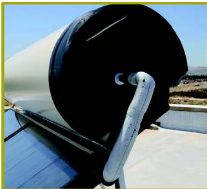
Raccordement et serrage de la tuyauterie eau chaude ballon-captteur
