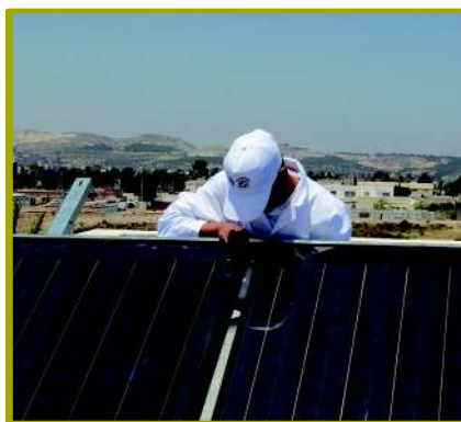
Serrage des fixations sur la traverse supérieure capteur
