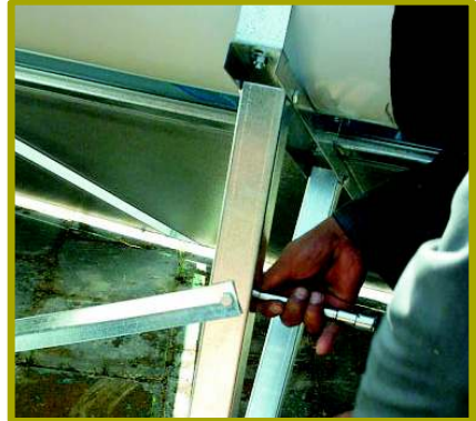
Serrage des croisillons de contreventement après montage du ballon
