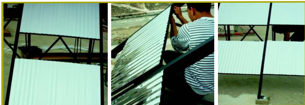
Fixation des réflecteurs sur la structure métallique
