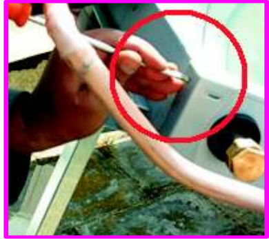
Contrôle des réservations drainage
