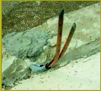
Vérification des attentes existantes et raccordement du nouveau circuit
