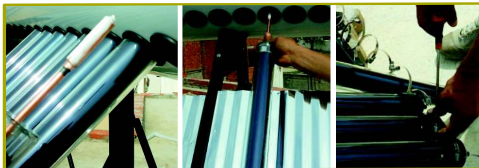
Enfilement des tubes dans le ballon et fixation sur glissière
