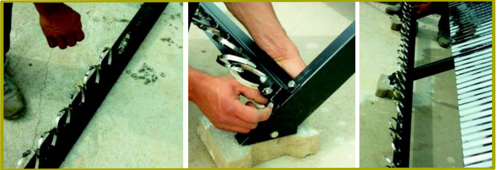
Insertion des colliers de fixation sur les glissières
