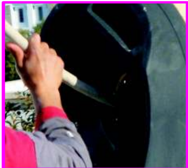
Nettoyage du ballon solaire par balai
