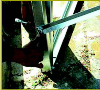
Serrage des croisillons de contreventement après montage du ballon
