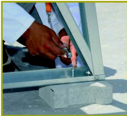
Pose des dalles de fixation du CESI avec vérification de l'alignement horizontal de l'ensemble de montage. Utiliser du mortier pour fixer les dalles au sol et des vis pour fixer la structure aux dalles
