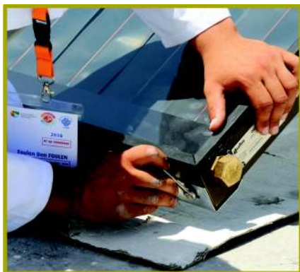
Serrage des fixations sur la traverse inférieure capteur
