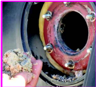
Nettoyage du ballon - extraction des dépôts de tartre
