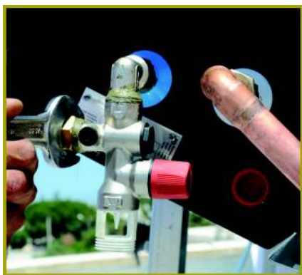
Remplissage du ballon pour rinçage, purge et élimination des divers déchets. Laisser l'eau couler pendant quelques minutes (2 à 5 mn)
