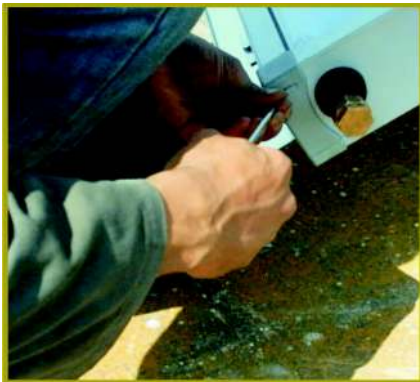
Perforation des réservations de drainage pour éviter les effets néfastes de la condensation dans les capteurs
