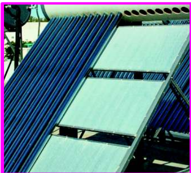
■ Tubes sous vide retirés pour réparation
