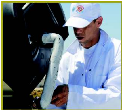
Raccordement et serrage de la tuyauterie eau chaude ballon-captteur
