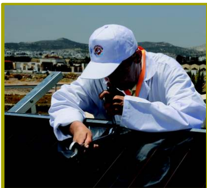
Serrage par clé et contre clé de la liaison supérieure capteurs
