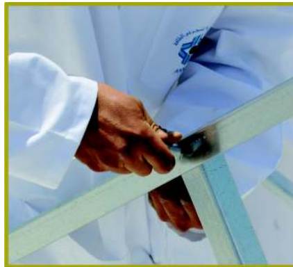
Assemblage au sol des supports triangulaires latéraux
