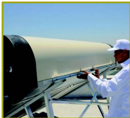
Mise en place centrée du ballon
