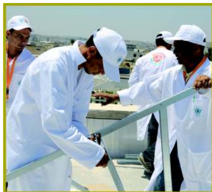
Assemblage au sol des supports triangulaires latéraux
