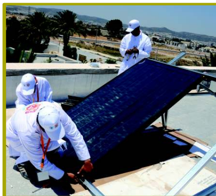
Mise en place des capteurs sur les traverses supérieure et inférieure
