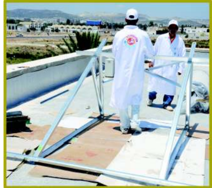
Montage des traverses capteurs - Renforcement de la structure par le montage des croisillons de contreventement
