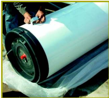
Mise en place des supports arrière ballon
