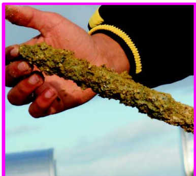
Contrôle et remplacement de l'anode
