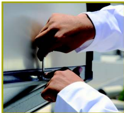
Serrage des fixations ballon sur la structure de support
